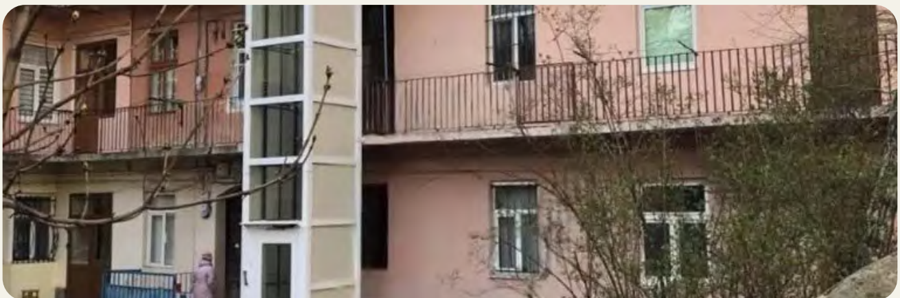
Рисунок 1.33. Приклад прибудови ліфта до галерейного будинку
