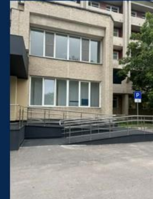
Безбар'єрний доступ від території до входу в будівлю, із паркомісцем для осіб з інвалідністю
